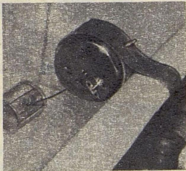
звонит на всю квартиру. Как крепится будильник металлической лентой к боковине ванны видно на фото.
